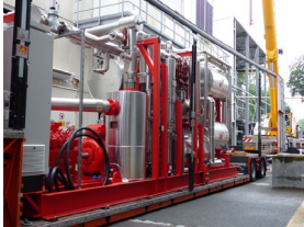
Abb1 Einbringung der Hochtemperaturwärmepumpe AGO Calora-Ago.jpg
