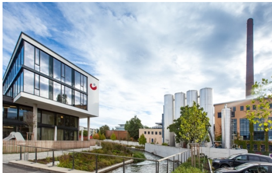
Abb. 1: Die Stadtwerke Rosenheim (Foto: Stadtwerke Rosenheim)
